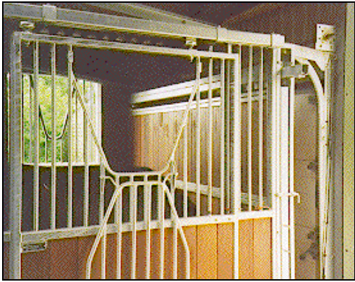
Figuur 22 Anti-weefrek dat kan worden afgesloten
