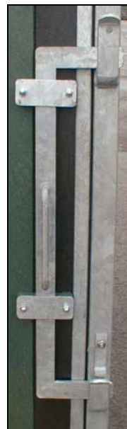
Figuur 24 Grendelsysteem voor scharnierende deuren
