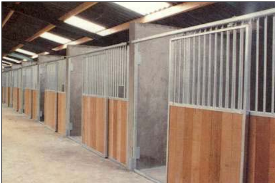
Figuur 5 Rij boxen met schuifdeuren en dichte tussenwanden
