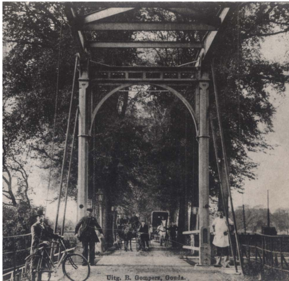
De ijzeren ophaalbrug over de Stolwijker Schutsluis aan het begin van de twintigste eeuw.
