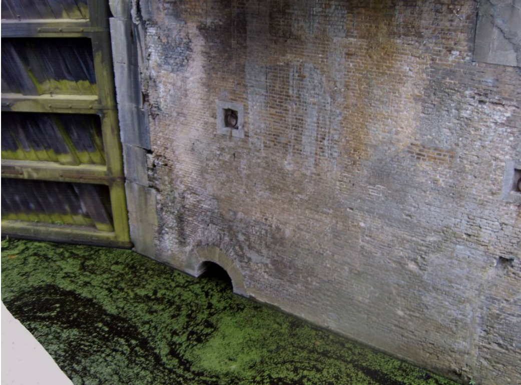
Oostelijke kolkwand met de opening van het omloopriool naar het buitenhoofd.
