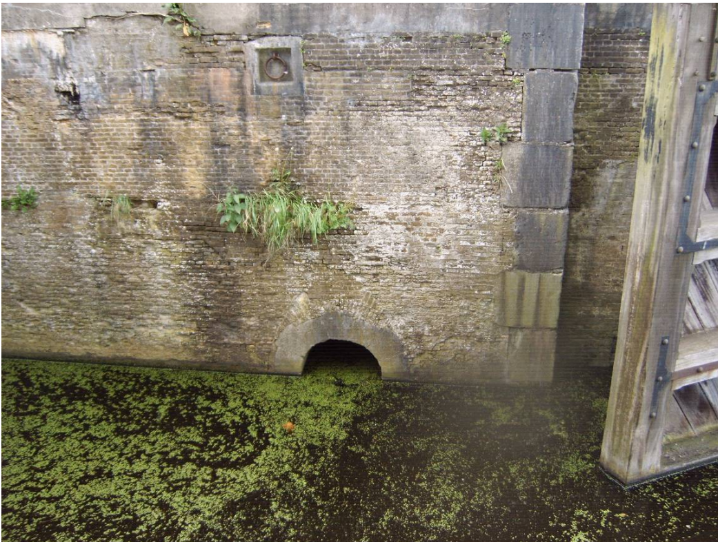
Oostelijke kolkwand met de opening van het omloopriool naar het binnenhoofd.
