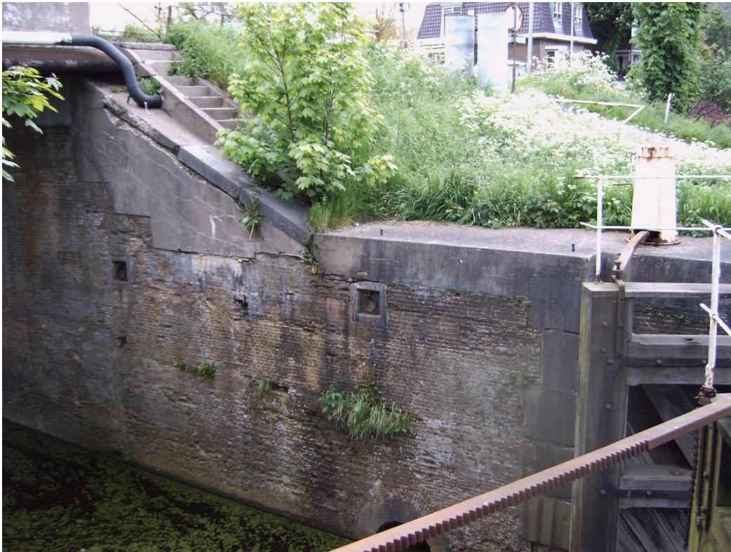
De oostelijke kolkwand gezien vanaf het binnenhoofd. Links de betonnen trap.
