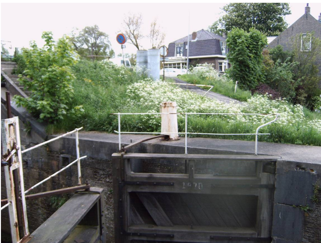
Het buitenhoofd gezien vanaf het binnenhoofd. In het midden het bewegingswerk voor de binnenvloeddeur en links het bewegingswerk voor de nivelleerschuiif.
