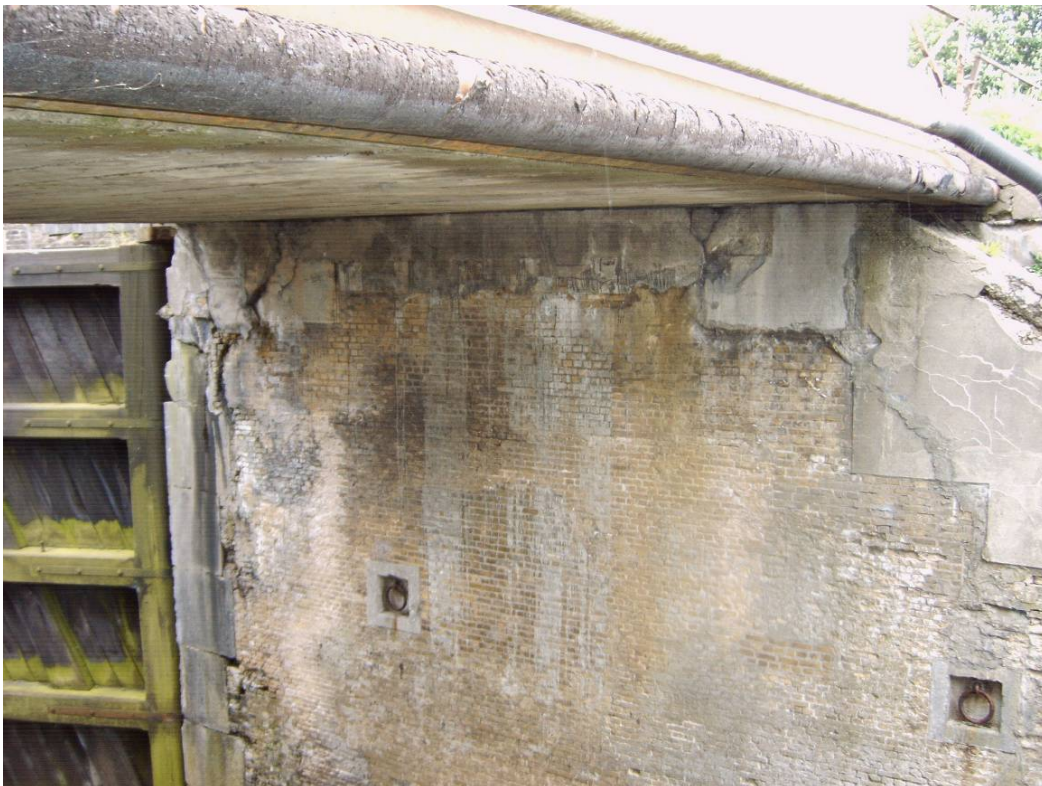
De oplegging van de vaste betonbrug op de oostelijke kolkwand. Links de buitenvloedeur.
