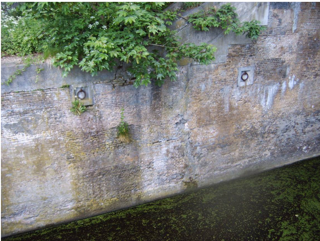
Westelijke kolkwand ter plaatse van de trap, met haalkommen met ijzeren ring.
