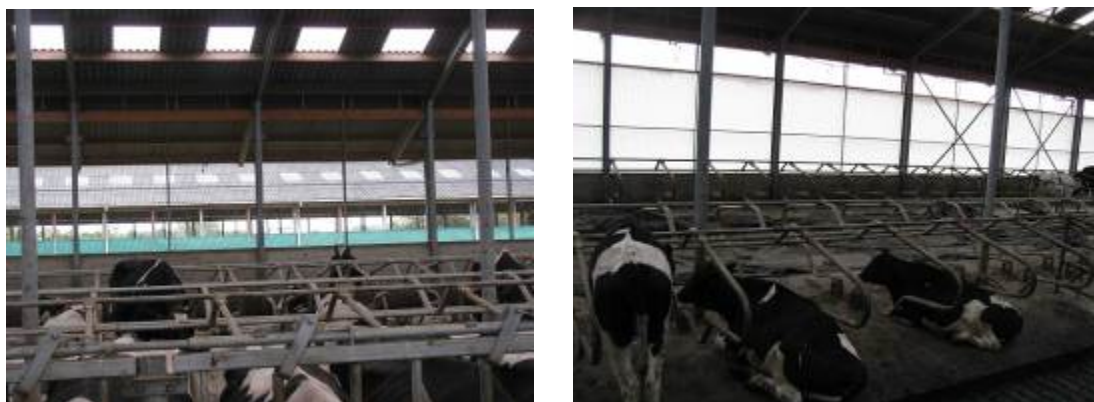
Figuur 2 Twee voorbeelden van ventilatieopeningen zoals toegepast tijdens de metingen. Links: inlaatopening bijna helemaal open; Rechts: verkleining van de inlaatopening
