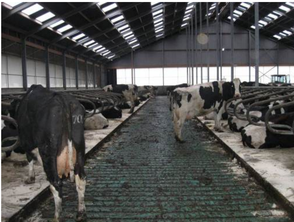
Roostervloer met BWL 2010.31 systeem
