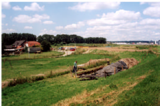
Zicht op de nieuwe en oude Malburgse dijk en proefsteuf
