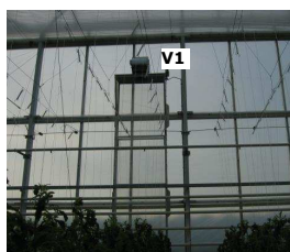
Figuur 1. Gevel unit met toevoerventilator V2 en verdeel en verwarmingsventilator V3 (links) en de afvoerventilator V1 (rechts).
