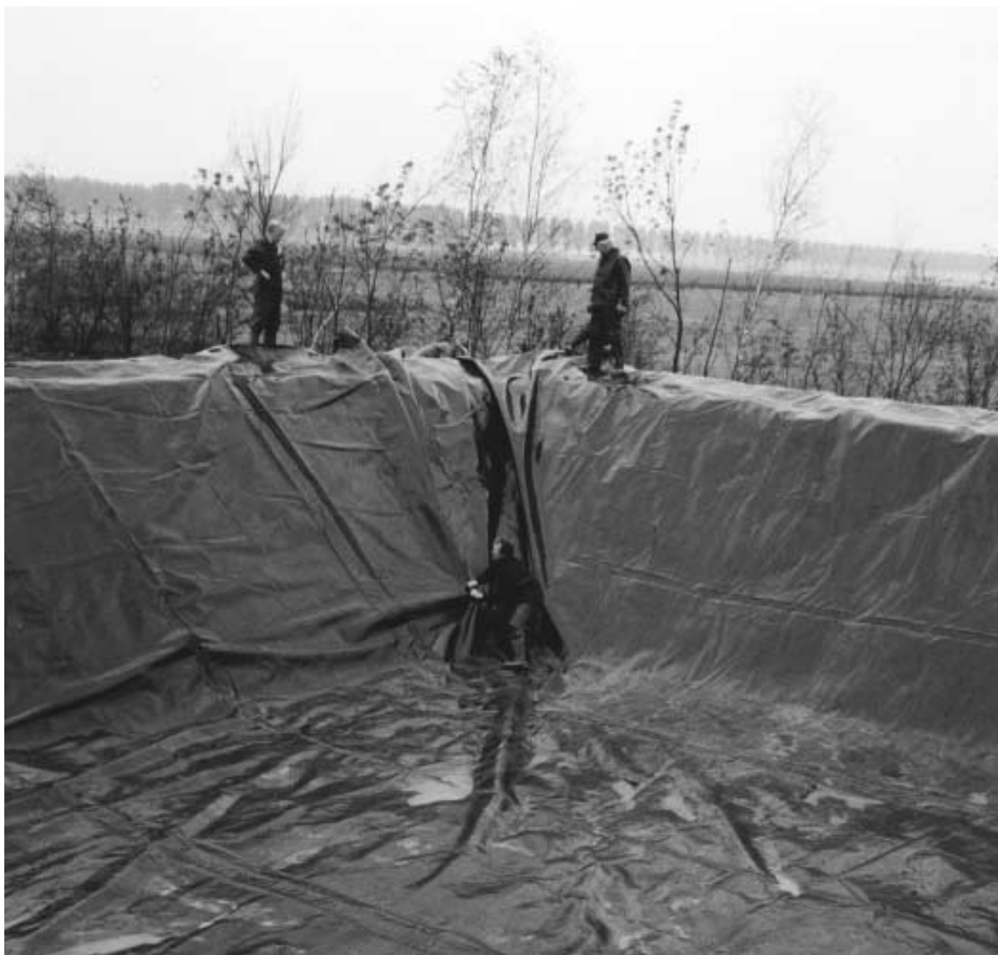
Een drijfslag in het foliebassin gaat ten koste van de inhoud, ook al wordt het bassin nog zo ruim aangelegd.....
