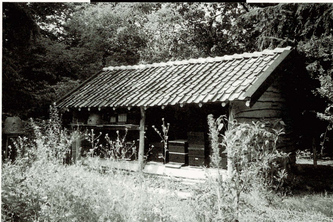
Op deze foto afgebeeld de bijenstal van J. Schep te Rijsbergen. Hier zijn verhaal. 'Ik heb de stal, samen met mijn zootjes, in het voorjaar van 1999 gebouwd volgens een bouwtekening van een bevriende architect die zelf ook imker is. De stal is geheel van hout, eiken palen en schaaldelen van lariks en gedekt met oud-Hollandse dakpannen. De stal staat vlak bij mijn woonhuis in het landgoed de Pannenhoef van Stichting 'Het Noordbrabants Landschap'. Rondom de bijenstal heb ik een bijentuin ingericht met planten als gele mosterd, boekweit, phacelia, zonnebloemen, rode klaver en incarnaatklaver.'
