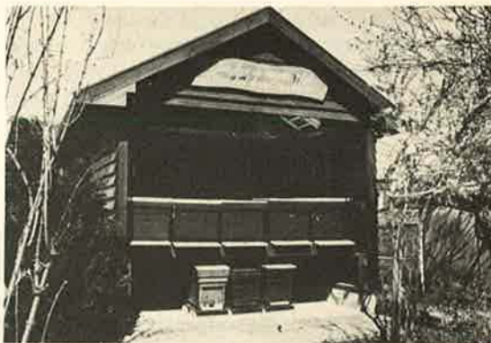
5. De eigen bijenstal, juist na de bouw.
