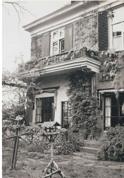
Zuidgevel. Het huis werd verbouwd in 1932 naar ontwerp van Reep VerLoren van Themaat. Een 19de-eeuwse serre werd afgebroken en vervangen door een terras. De woonkamer kreeg ramen in stalen kozijnen (foto's 1974).
