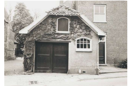
De garage, vermoedelijk deels bestaand uit voormalige stallen, ingekort in 1916–1918 en verbouwd in 1932 (foto 1974).
